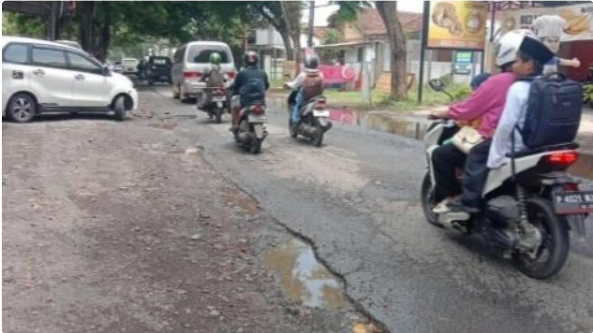
(Kondisi ruas Jalan Kepiting Kelurahan Tukangkayu, Banyuwangi)
