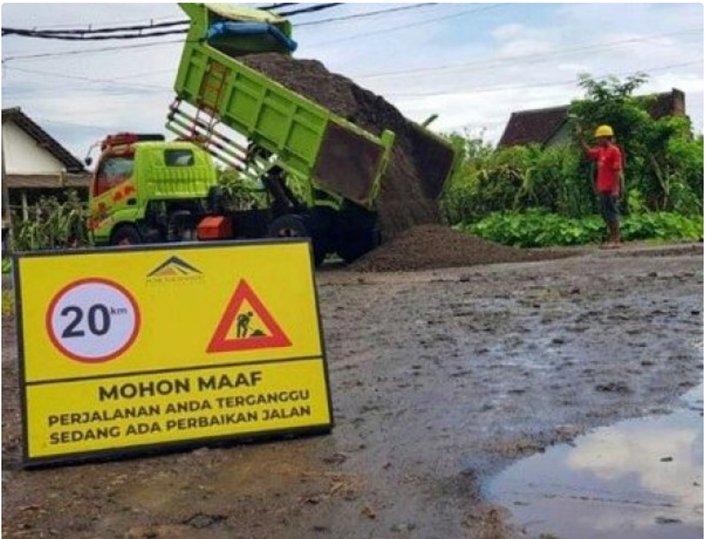
Perbaikan jalan rusak di Banyuwangi
